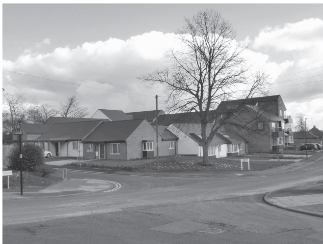
写真8 シェンリー・グリーン 完成後。写真7とほぼ同じ西側か らのアングル。敷地西端の樹木が 保全されたことが分かる。(2014年 3月1日撮影)
