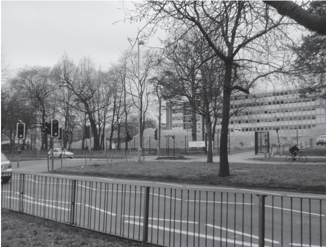
写真17 解体途中のボーンヴィル・カレッジ 鉄筋コンクリートの建物の手前には、煉瓦クズの山ができています。 (2012年3月17日撮影)
