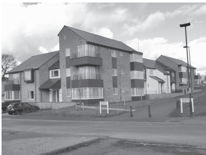
写真9 シェンリー・グリーン 完成後。南側からのアングル。 (2014年3月1日撮影)
