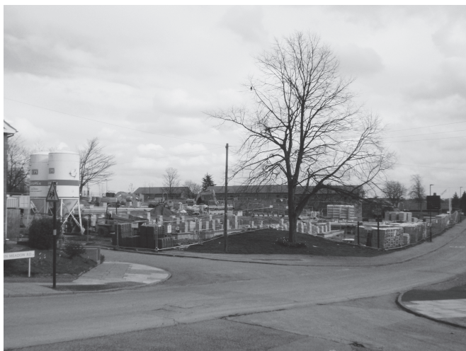
写真7 シェンリー・グリーン 建設着工直後。建設予定地に資材 が置かれている。(2012年3月18 日撮影)
