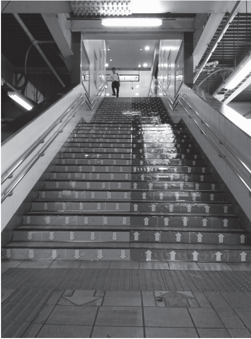
図8 三鷹駅中央線ののぼりホームの階段（2014年5月撮影）
