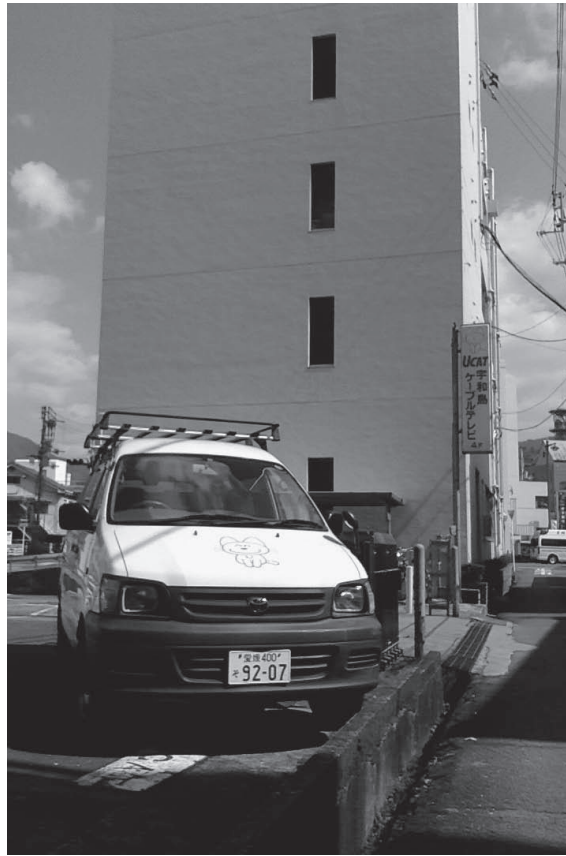
写真3 宇和島ケーブルテレビ（UCAT/FMがいや）が3-4階に入っている建物。裏手の駐車場側から。
