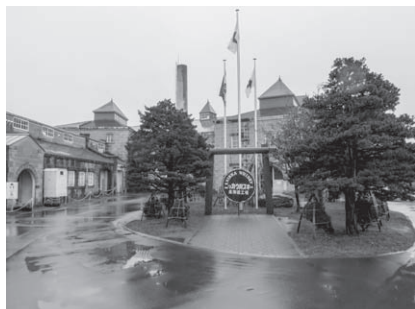
図 31 余市蒸留所の外観
