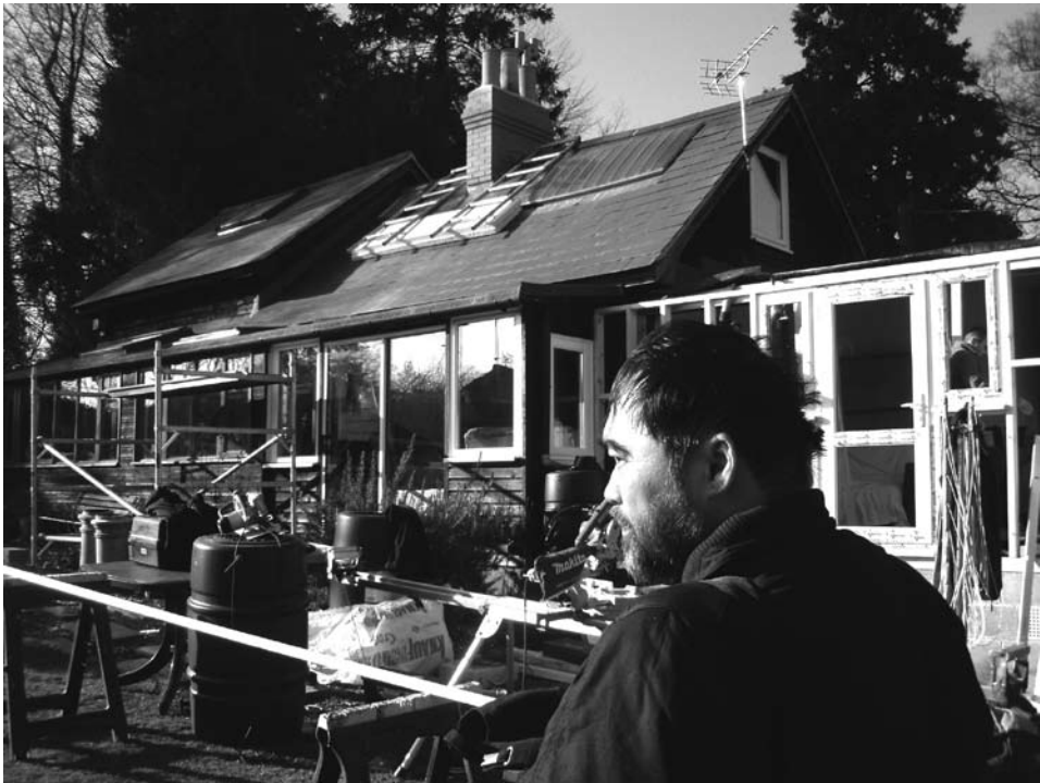
写真18 増築を重ね、現在も改装工事中のマランの家★
