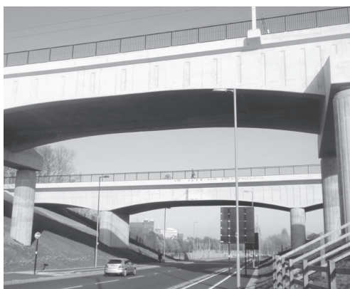
写真 10 A38 バイパス。東方向に撮影。手前が鉄道橋、奥が運河橋。運河橋上には歩行者が見える。
