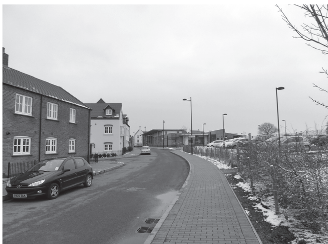
写真4 ヴィレッジ・センター街区 正面奥が小学校兼コミュニティ・センターの建物。右手は球技場と公共緑地。左手に並ぶのが住宅棟。路上駐車も見えるが、各戸には裏手に駐車場が確保されている。
