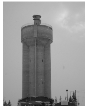
(写真10) アンテナは3 km ほど離れた浄水タンクの上
