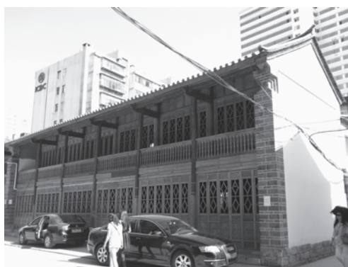
図10 修復後の街並み（南強街）
