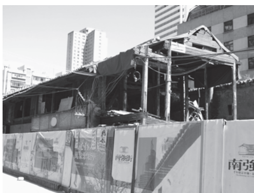
図9 修復に向けて解体中の街並み（南強街）
