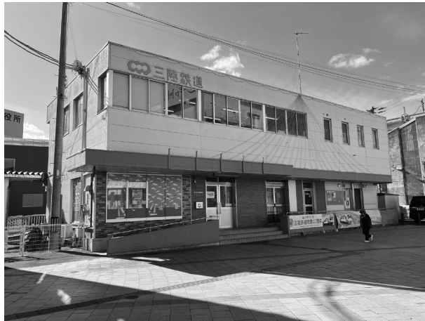
写真1 宮古エフエム放送が入居する三陸鉄道本社社屋 2024年2月9日撮影 (筆者撮影)
