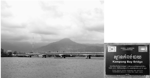
写真1 韓国のODAで建設された国道3号線のコンポ ンバイ橋（コンポート市内）
