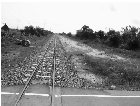
写真5 改修の終わった南部線（コンポート郊 外）
