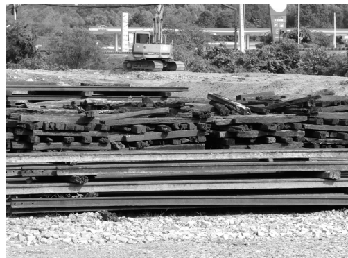
写真6 改修によって撤去された木製枕木と古 いレール
