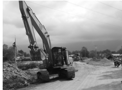
写真2 舗装が陥没してADBとオース トラリアの援助で改修の続く3号線
